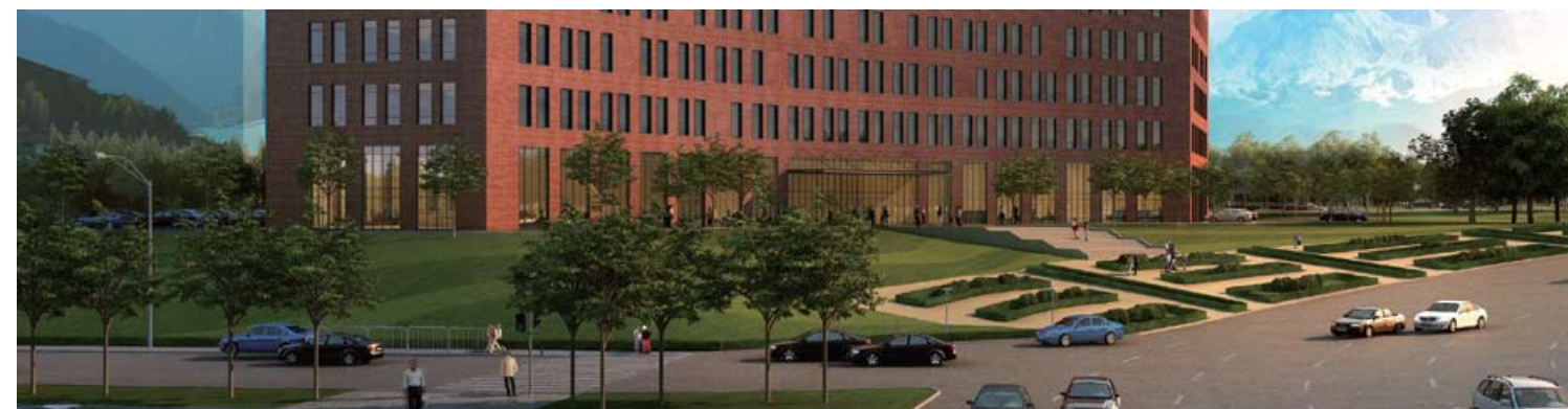
新疆档案馆新馆主入口开放广场
