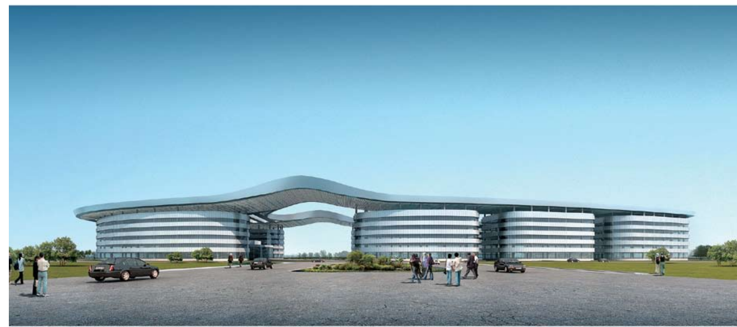
项目名称：上海飞机制造有限公司制造工程技术大楼 设计时间：2011-2013年 项目面积：6.5万m 2
