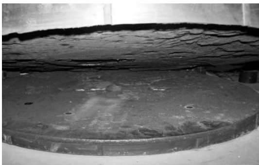
图4 隔震支座破坏形态 (试件LNR1)
