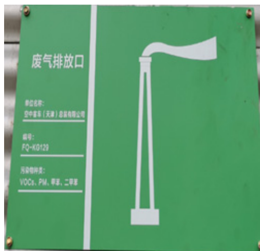
图 3.6-4 DA003 排气筒及标识
