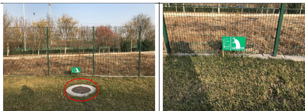
图 3.6-8 4 号废水总排口及标识
