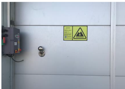
图 3.6-9 危险废物暂存间内警示标识
