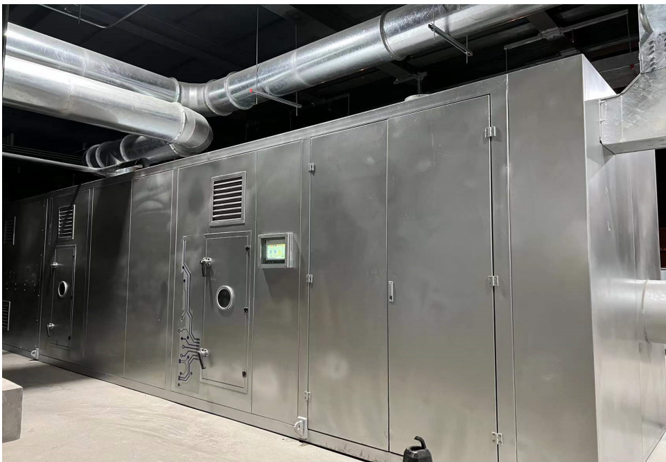
图 9.2-4 调漆间撬装式一体机设备安装实物图
