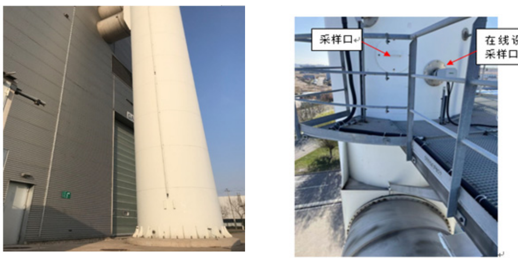
图 3.6-3 DA002-1、DA002-2 排气筒及标识
