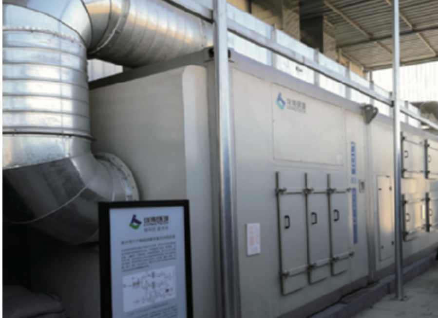
图 9.2-7 廊坊思铂利汽车维修服务有限公司废气净化装置实物图
